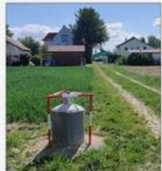
19 neue Wasser-Messpegel wie hier in Kirchdorf wurden 2019 installiert. Noch fehlen die Vergleichswerte, erst in Jahrzehnten kann man sehen, ob die Grundwasserstände hoch oder niedrig sind. – Foto: Wasserwirtschaftsamt
