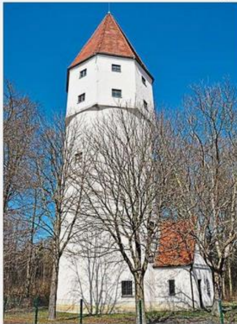
Über den Wasserturm in Altenmarkt gelangt das Trinkwasser mit einem Druck von 2,5 bar in die Leitungen der Haushalte. Bis 1994 stammte dies aus eigenen Grundwasserbrunnen. Weil die Nitrat-Grenzwerte überschritten wurden, erfolgte der Vollanschluss an den Wasserversorger „Waldwasser“. Jetzt dient der Turm mit 250 Kubikmetern Wasser als Reserve für Osterhofen und Altenmarkt. – F: gs
