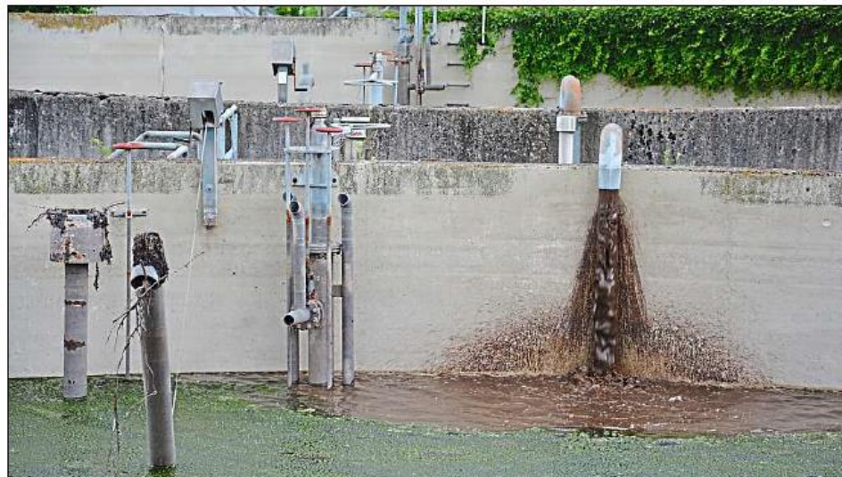
In der Kläranlage im Osterhofener Ortsteil Blaimberg plätschert der Klärschlamm in zwei große Becken. Über eine mobilen Anlage wird er bislang auf einen Trockensubstanzgehalt von 25 Prozent getrocknet und dann zur Rekultivierung abtransportiert. – Foto: Schiller
