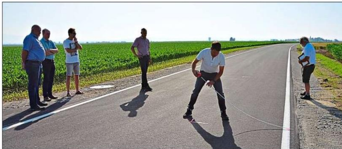
In der Mitte zwischen beiden Ortschaften weist die neue Straße noch eine kleine Unebenheit auf, die sofort heraus gemessen wurde.
