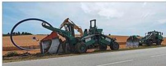
Das Aufpflügen des Erdreichs sowie das Einziehen der neuen Leitung erfolgte in einem Arbeitsgang. Die Verbindungsleitung wurde auf öffentlichem Grund verlegt, doch die Fahrzeuge mussten dazu zum Teil Felder und Privatgrund nutzen. Stadt, Stadtwerke, Planer und ausführende Firma danken den Anwohnern. – Fotos: Seidl
