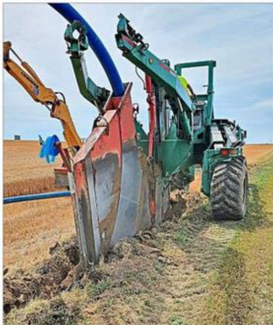
Zwei Meter hoch ist das Pflugschwert, mit dem die neue Leitung zwischen Ruckasing und Mühlham eingezogen wurde.
