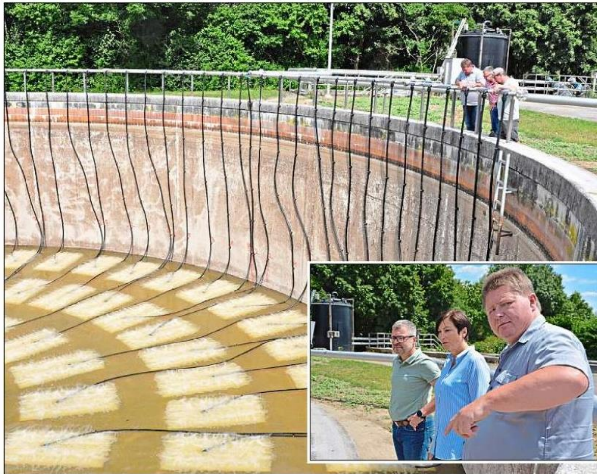
Bessere Energie- und Reinigungseffizienz: Durch die neuen Bodenplatten sprudelt mehr Sauerstoff ins Klärbecken. Stadtwerkeleiter Reinhold Seidl (v.l.), Planerin Claudia Scharnagl und Klärwärter Norbert Leitl sind mit dem Ergebnis zufrieden. – Fotos: Schwarzbözl/ Schiller
