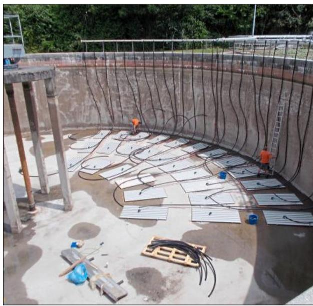
Damit die Bakterien optimale Fressbedingungen vorfinden, ist in den Osterhofener Kläranlagen die Belüftungstechnik erneuert worden.
