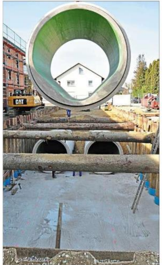
Elf Tonnen wiegt das Betonrohr, das in die Baugrube gesenkt wird. Insgesamt werden die beiden Rohre 35 Meter lang und künftig als Stauraumkanal dienen.
